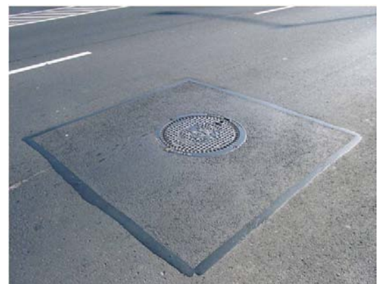
Vertikálne použitie tesniacej pásky DUNAFLEX napr. rozmeru 40x8 mm po 2 rokoch
