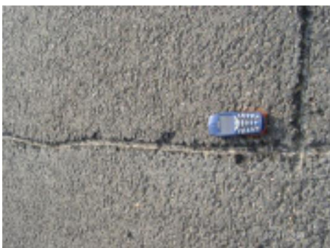
1. Náročné zafrézovanie praskliny.
