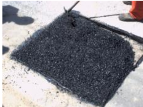
4. Prepojenie starého asfaltu s horúcou asfaltovou zmesou pomocou zatavenej pásky Dunaflex.
