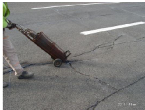
2. Roztavenie asfaltu vozovky horúcim vzduchom, resp. penetrácia praskliny a okolia.
