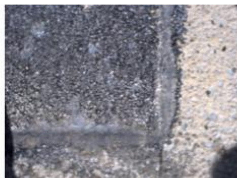
6. Presah pásky po zavalcovaní vodotesne zapečiatí spoj.
