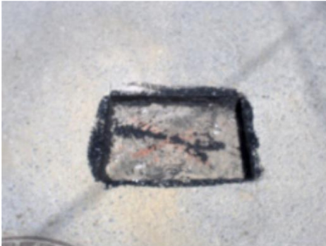
1. Vyrezanie výtlku a penetrácia stien výrezu ak je to potrebné.
