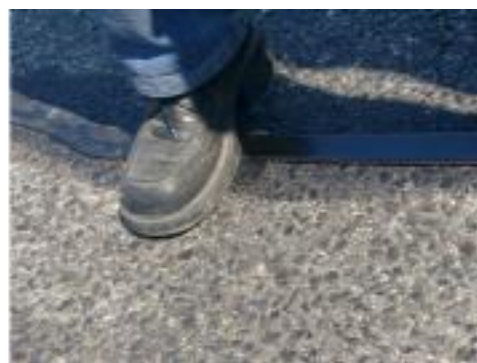
4. Pritlačenie pásky na prasklinu nohou, resp. valčekom.
