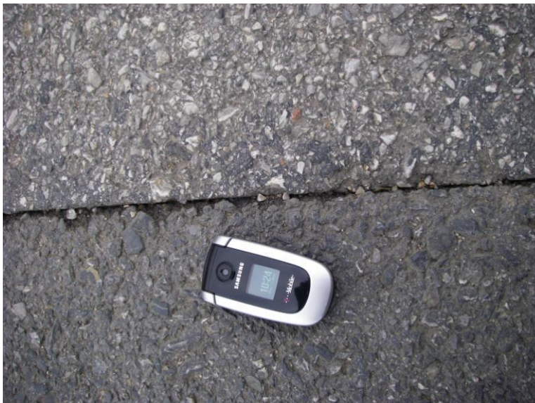
Ukážka nevhodnosti používanej technológie v súčasnosti. Nezabezpečená vodotesnosť a bezerozívnosť prepojenia asfaltov.
