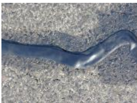
5. Prekrytie a utesnenie praskliny vyformovanou páskou.
