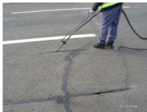
4. Aplikačná pištoľ uľahčuje presné smerovanie a dávkovanie asfaltovej zálievky do prasklín.
