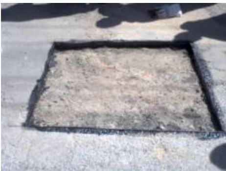
3. Výrez s páskou pripravený na aplikáciu asfaltovej zmesi.
