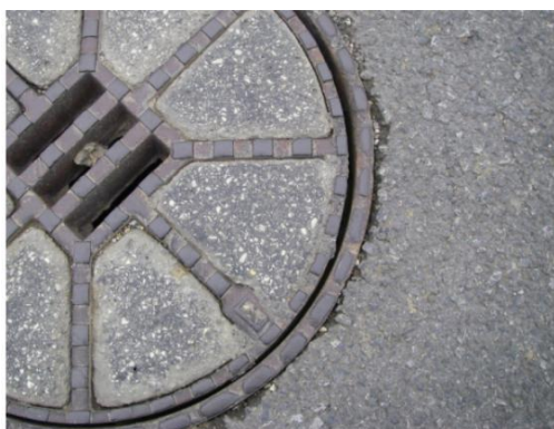
Otváranie spoja - vplyv rozdielnej dilatácie.
