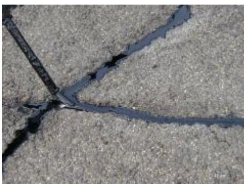
5. Vyplnenie praskliny roztavenou asfaltovou zálievkou.
