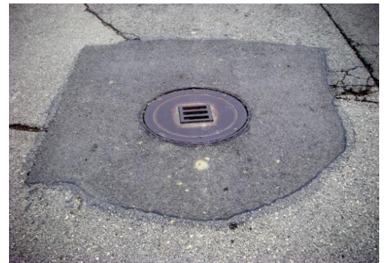
Vertikálne použitie tesniacej pásky DUNAFLEX napr. rozmeru 40x8 mm po 2 rokoch
