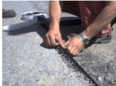
2. Aplikácia samolepiacej pásky DUNAFLEX s presahom 3-4 mm nad okraj vozovky.
