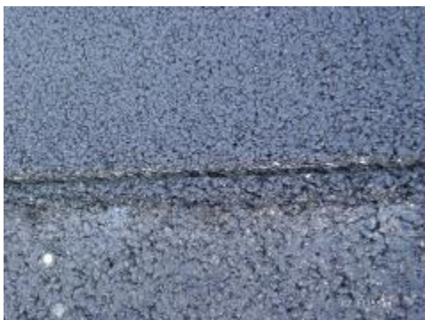
1. Hrana novo položeného asfaltového krytu.
