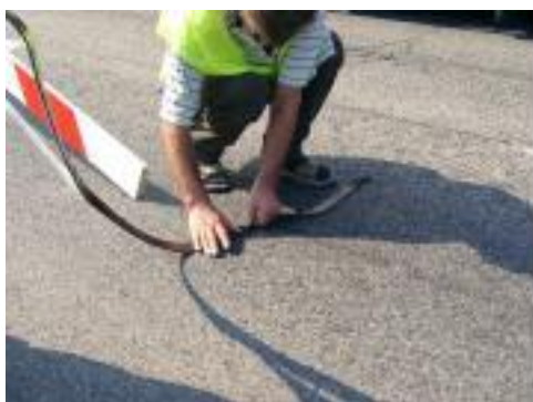
3. Jednoduchá aplikácia tvarovateľnej samolepiacej pásky.
