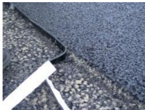
2. Na zarezanú hranu asfaltového koberca sa samolepiacou stranou nalepí páska.
