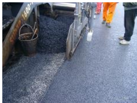
4. Finišér položí druhý asfaltový koberec.
