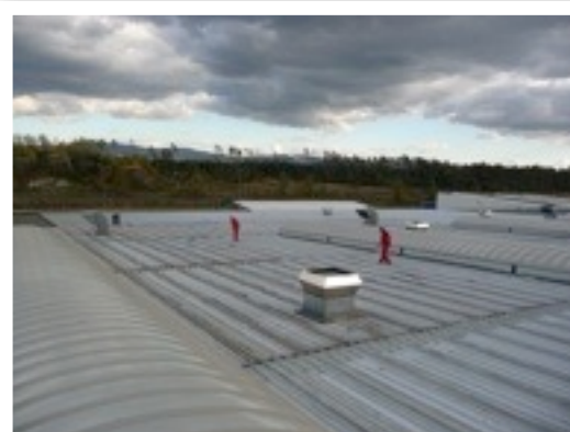
Aplikácia striekaním plech.strecha 1400m 2
