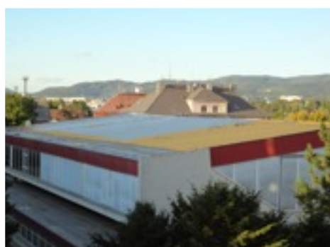
Hydroizolacia T.G na PUR
