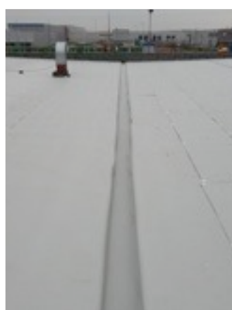
Hydroizolacia špec.membrány TG
