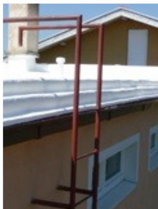
Hydroizoalcia špec.membrány TG +zateplenie
