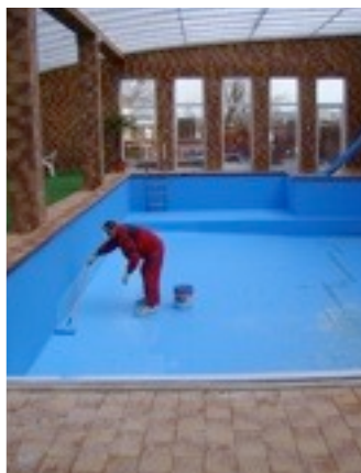
Aplikácia náterom bazén 280m 2
