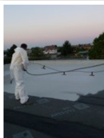
Aplikácia striekaním špec.membrana 340m 2
