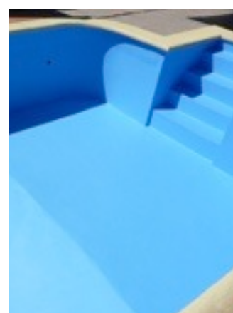
Aplikácia striekaním bazén 200m 2
