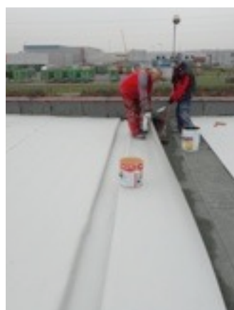
Hydroizolacia špec.membrány TG
