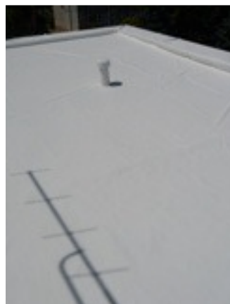
Hydroizolácia špec.membrány TG +zateplenie
