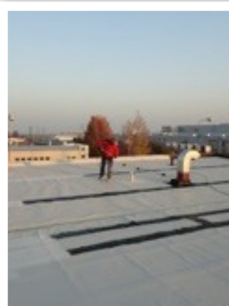
Hydroizolacia špec.membrány TG
