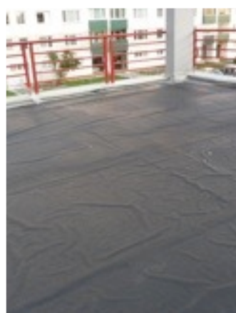
Hydroizolacia špec.membrány TG
