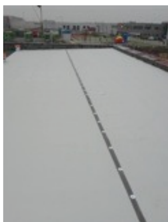
Hydroizolacia špec.membrány TG
