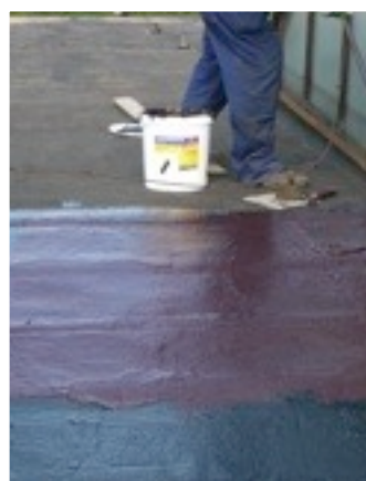
Aplikácia náterom asf.strecha 2400m 2
