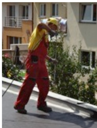
Hydroizolacia špec.membrány TG
