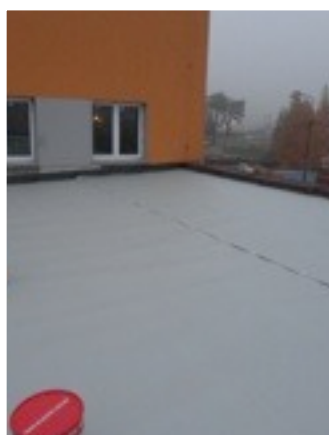
Hydroizolacia špec.membrány TG
