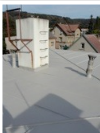
Aplikácia striekaním plech.strecha 320m 2
