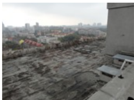
Oprava starej strechy
