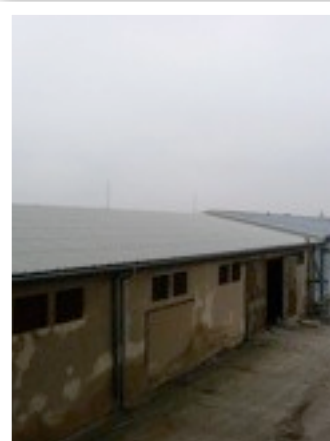
Aplikácia striekaním plech.strecha 1400m 2
