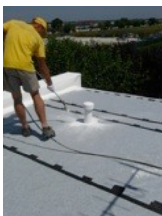
Hydroizolácia špec.membrány +zateplenie
