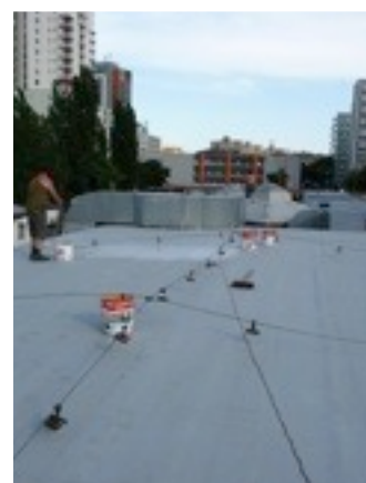
Aplikácia náterom asf.strecha 480m 2
