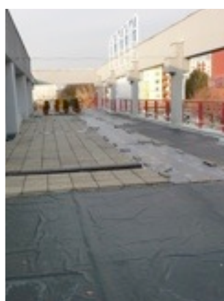
Hydroizolacia špec.membrány TG
