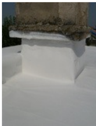
Hydroizolacia špec.membrány TG +zateplenie
