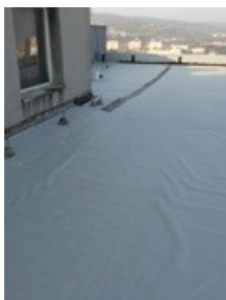
Hydroizolacia špec.membrány TG
