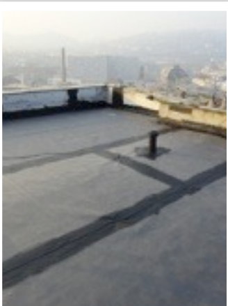
Hydroizolacia špec.membrány TG
