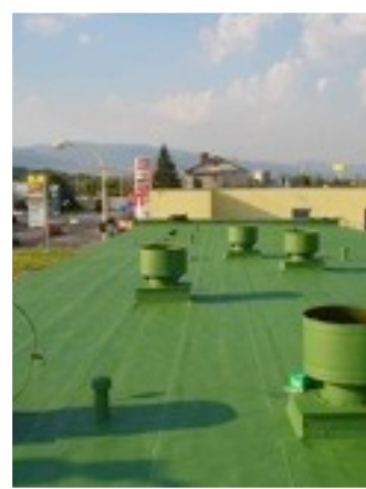
Aplikácia striekaním asf.strecha 700m 2
