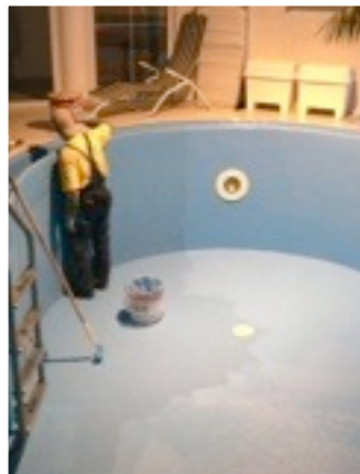
Aplikácia náterom bazén 120m 2
